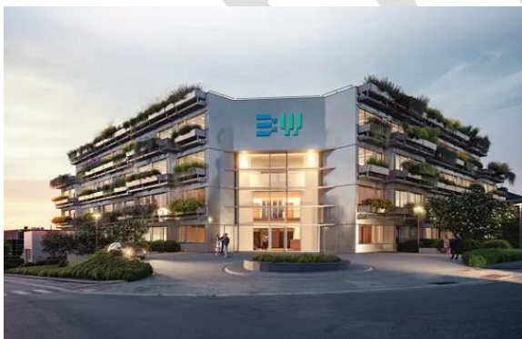
FIGUUR 2: BIJ DE RENOVATIE VAN HET NIEUWE KANTOORGEBOUW VAN BUILDWISE WERD ERVOOR GEKOZEN OM DE BETONNEN STRUCTUUR TE BEHOUDEN. HIERMEE WERD BIJNA 60% EMBODIED CO2 UITGESPAARD, DANKZIJ HET NIET HOEVEN PRODUCEREN EN BOUWEN VAN EEN NIEUWE BETONSTRUCTUUR.
